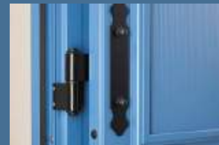
Détail montage gonds sur précadre
